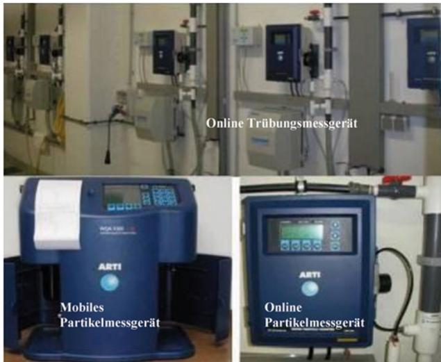
**Abb. 4** Online Partikel- und Trübungsmessgeräte und mobiles Partikelmessgerät im WW Irsch
