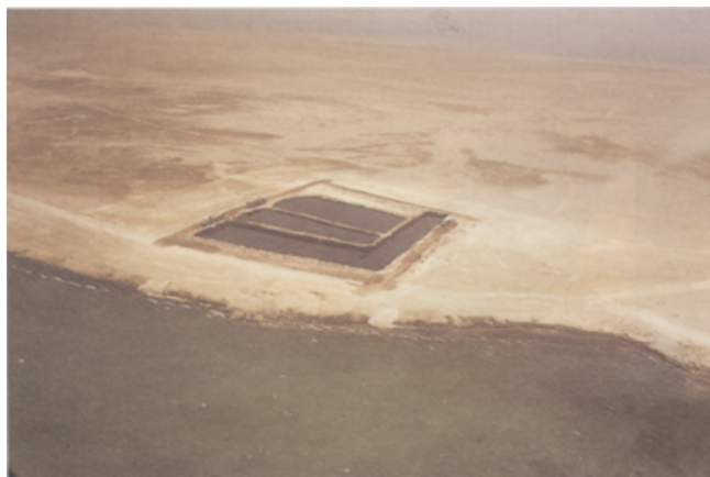
Abb. 3: Eines der Zwischenlager für abgeschöpftes Öl. Am linken Rand des Pools sind zwei Tankwagen zu erkennen, die Öl zum Transport in die Raffinerie entnehmen.
